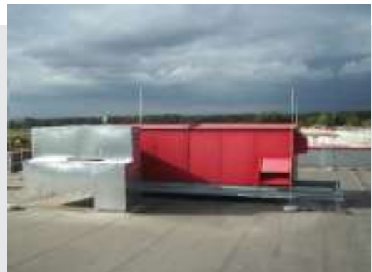
Şekil 7: Bina merkezli havalandırma cihazlarının çatı üstü montajı (kaynak: Lüfta GmbH)
