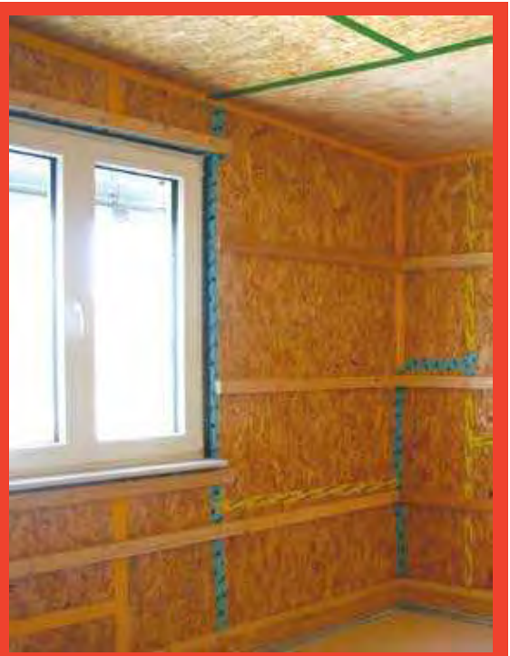
Ahşap kompozit levhalar arasında hava sızdırmaz bağlantılar
