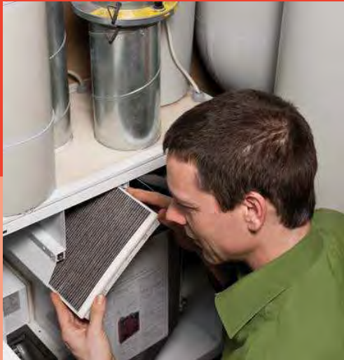
Havalandırma ünitesinin filtresinin değiştirilmesi
